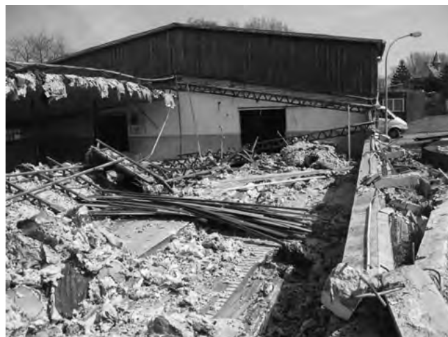
Figure 2.4.2.1.1: démolition d'un bâtiment pour des bovins: le tri des anciens matériaux de construction est obligatoire en application des nouvelles législations environnementales.
